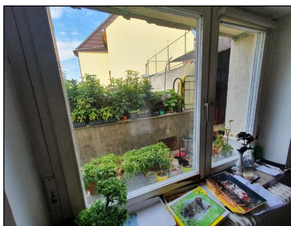
Slika 31: Okno A1 iz notranjosti
