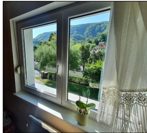
Slika 5: Okno A2 iz notranjosti
