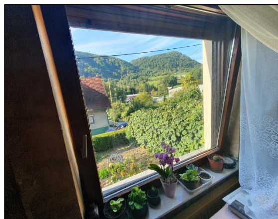
Slika 48: Okno A1 iz notranjosti
