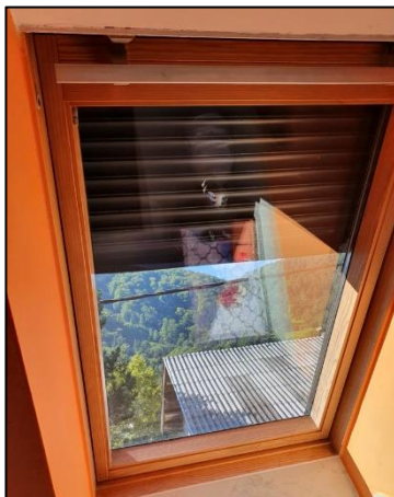
Slika 39: Okno A4 iz notranjosti
