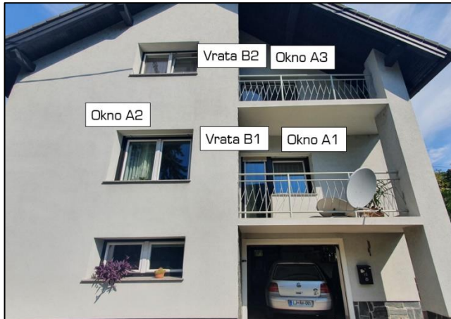
Slika 4: Južna fasada objekta
