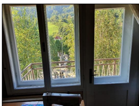
Slika 12: Okno A4 in vrata B2 iz notranjosti
