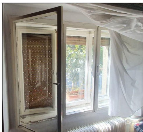
Slika 33: Okno s kasetno zasteklitvijo iz notranjosti
