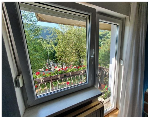
Slika 9: Okno A1 in vrata B1 iz notranjosti
