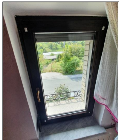
Slika 58: Okno A3 iz notranjosti
