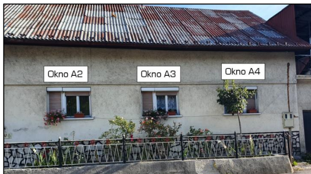
Slika 29: Južna fasada objekta
