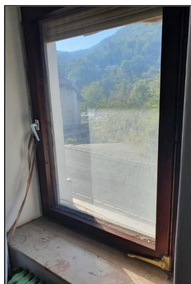
Slika 56: Okno A5 iz notranjosti
