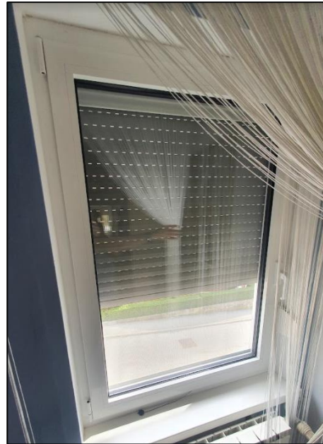
Slika 18: Okno A1 iz notranjosti
