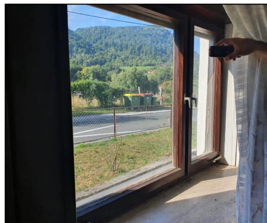
Slika 54: Okno A1 iz notranjosti
