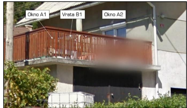
Slika 14: JZ fasada objekta
