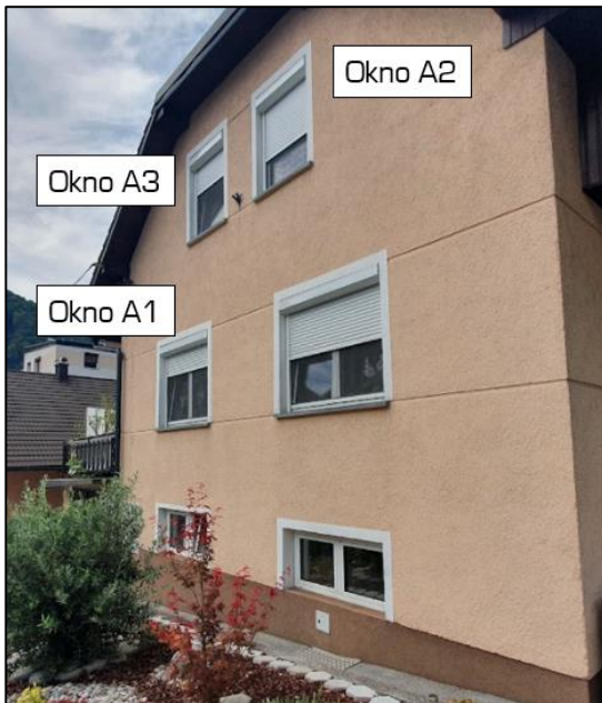
Slika 17: Vzhodna fasada objekta
