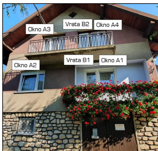
Slika 8: Južna fasada objekta
