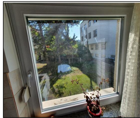
Slika 21: Okno A1 iz notranjosti
