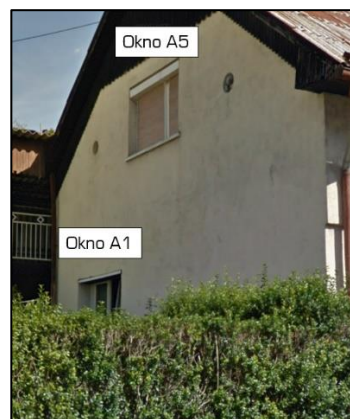
Slika 30: Zahodna fasada objekta
