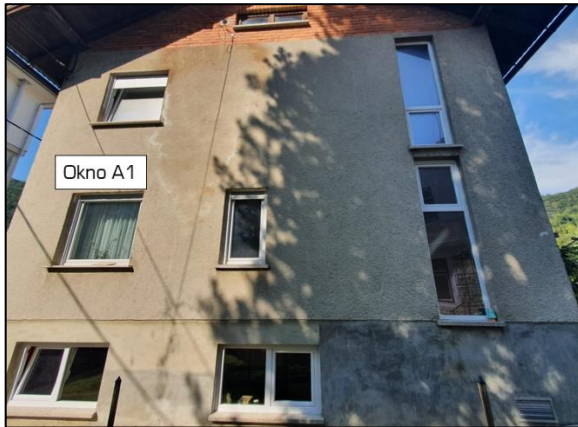
Slika 20: Vzhodna fasada objekta
