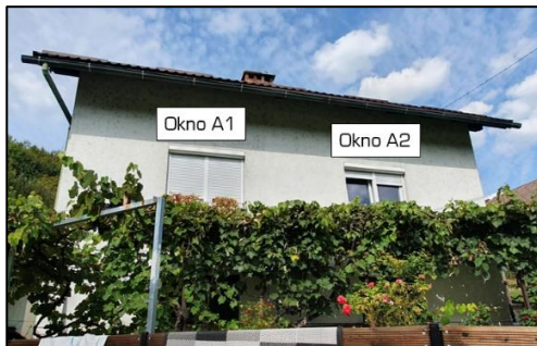
Slika 1: Južna fasada objekta
